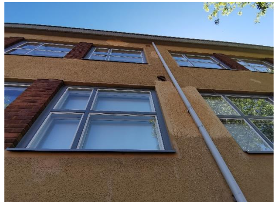
Kuva 13 Paikkakorjauksia B-osan länsisivulla.
