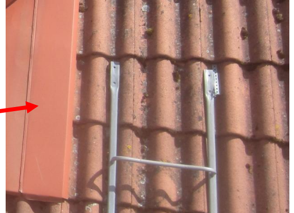
Kuva 32 Tikkaiden kiinnitys puutteellinen. Kuva 33 Tikkaiden kiinnitys puutteellinen.
