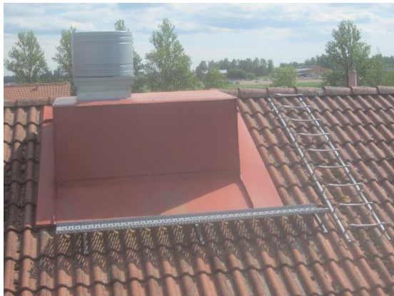
Kuva 30 Vesikatolla kulkee kulkureittejä tärkeimmille huoltokohteille.
