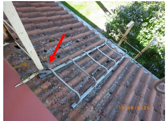
Kuva 31 Matalan siipiosan lapetikkaiden kiinnitys puutteellinen. Tikkaat ovat kiinni vain reikävanteella talotikkaissa
