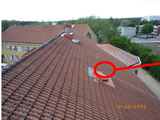
Kuva 32 Tikkaiden kiinnitys puutteellinen. Kuva 33 Tikkaiden kiinnitys puutteellinen.
