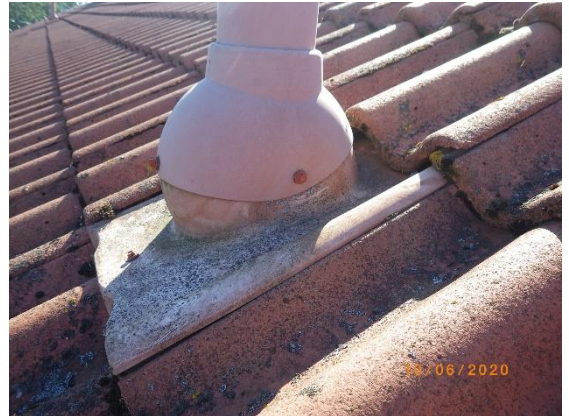
Kuva 23 Viemärintuuletusputken läpivienni.
