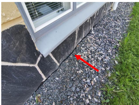
Kuva 8 Perusmuuria vasten todettiin useammassa kohdassa olevan perusmuurilevy.
