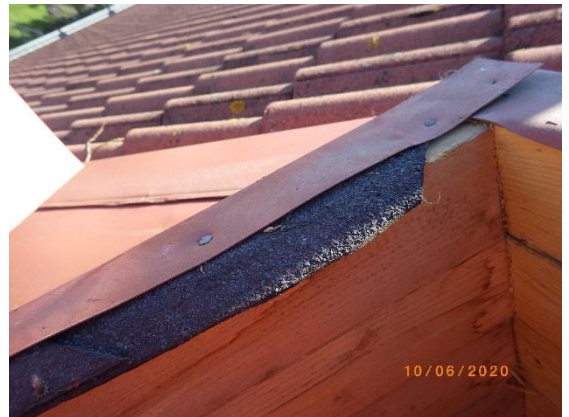
Kuva 25 Aluskate on nostettu asian mukaisesti kattoluukkurakenteita vasten.
