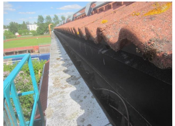
Kuva 37 Kourissa kulkee sulatuskaapeli ja paikoin on kerääntynyt likaa ja roskaa.
