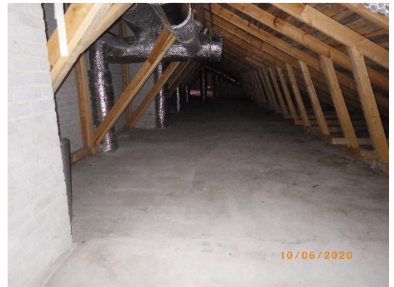
Kuva 17 Yleiskuva A-osan yläpohjatilasta.
