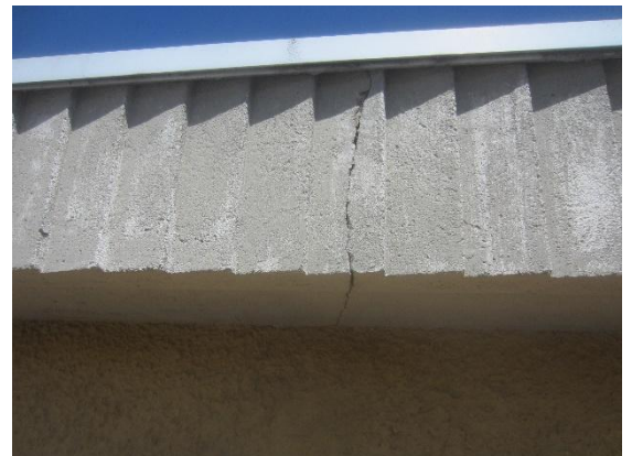
Kuva 35 Halkeama räystäässä.
