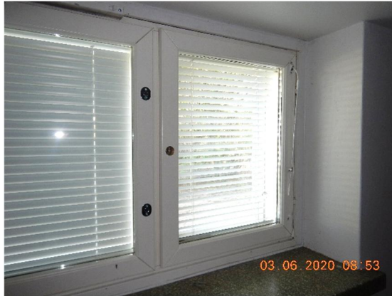
Kuva 38 Sisäpuitteiden puuosat ja maalipinnat ovat pääosin hyväkuntoiset.
